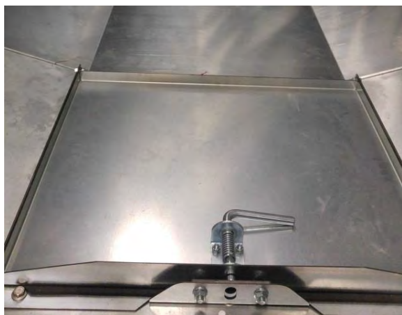
Image 35 – Plenum divider door
