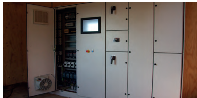
PC/PLC Steuerungen für große Anlagen mit Touch-Screen mit Touchscreen zur Steuerung und Überwachung der gesamten Anlage.
