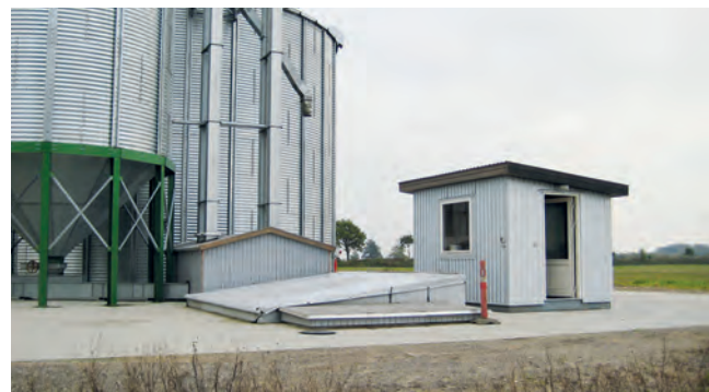
Siloprojekt med hus för styrtafla, fördelnings tavla samt plats för ett bord med tex vattenhalts mätare och god utsikt över tippgröp och plan.
