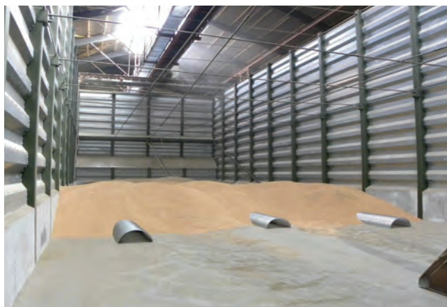
Kanalavstånd vid torkning: spannmål 100 cm, Frö 80 cm
