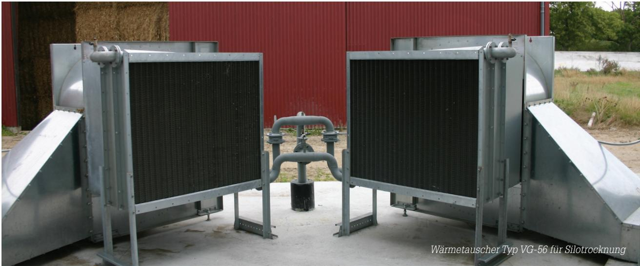
Wärmetauscher Typ VG-56 für Silotrocknung
