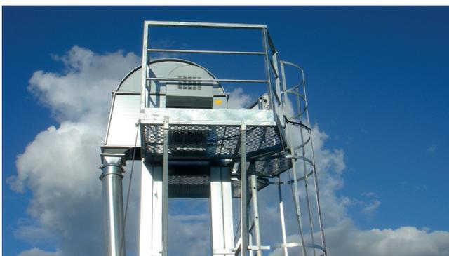
▲ Eine Service Plattform für freistehende Becherelevatoren sowie Leiter mit Rückenbügel lieferbar.
