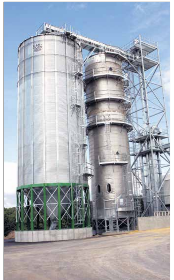
Overgaard Gods har taget et nyt tørreri i brug. Tørreriet håndterer 130 ton hvede i timen, som kan tørres fire procent ned. Energikilden er gas. (Fotos: Jens Mathiasen)
