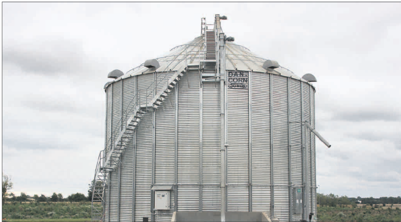
Amerikanersilo med spindeltrappe. Der er krav om, at der for hver tre meter trappe skal være en hvileplatform.
