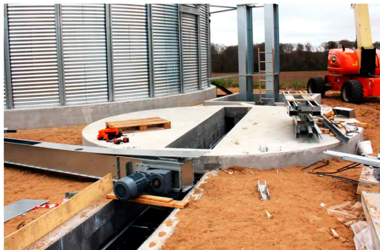
■ Fundamentet til forsiloen med en kapacitet på 200 tons. Det mobiletørreri bliver placeret ved siden af kornelevatoren.
